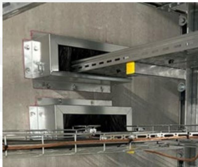
Le NuPLUG\_I04 est un boîtier utilisé pour le calfeutrement coupe-feu de passages de câbles.
