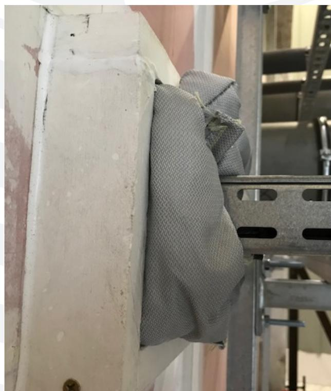
BagPART est un sac coupe feu intumescent destiné au calfeutrement de passage de câbles en dalle, voile et cloison sèche.
