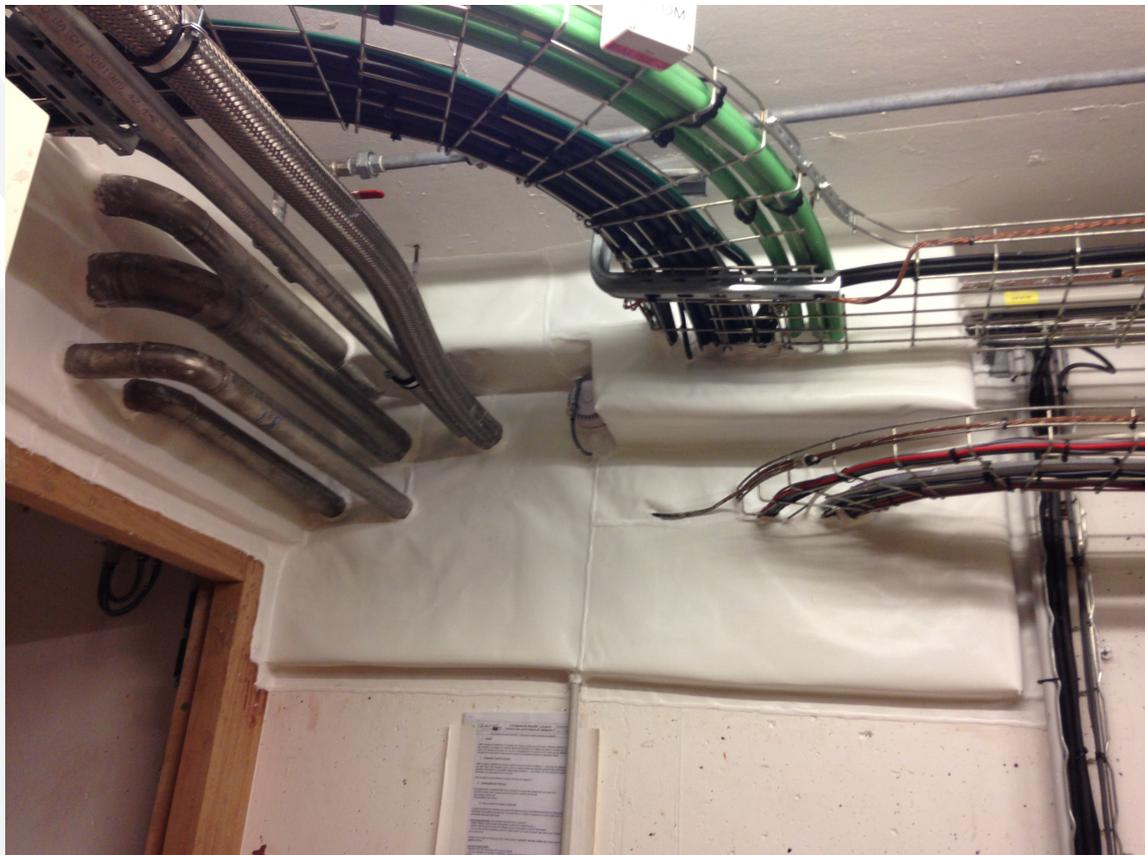
PlugPART 5110 est un complexe multi-composant coupe-feu, utilisé pour les calfeutrements de traversées électriques, mécaniques, vierges et mixtes, en voile ou en dalle.
