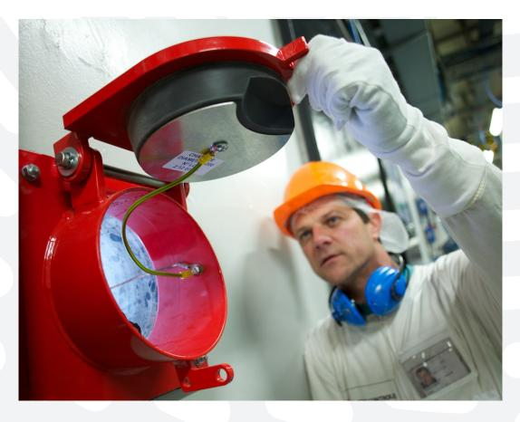
La NuCAT 5210 F permet le passage provisoire de câbles d'un local à l'autre. En cas d'incendie, elle assure l'intégrité coupe-feu de la paroi dans laquelle elle est installée
