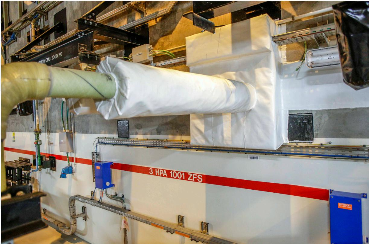
NuPLUG 5110 est un complexe multi-composant coupe-feu, utilisé pour les calfeutremments de traversées électriques, mécaniques, vierges et mixtes, en voile ou en dalle.
