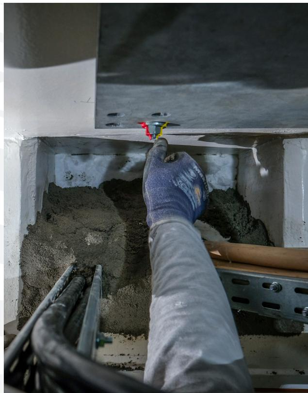
NuPLUG 1120 est un mortier utilisé comme barrière radiologique et coupe-feu dans le calfeutrement de traversées, principalement dans les centrales nucléaires ou autres sites nucléaires
