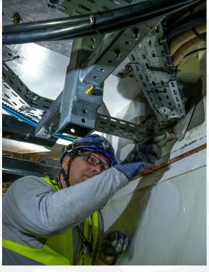
NuPLUG 1110 est un mortier utilisé comme barrière coupe-feu dans le calfeutrement de traversées, principalement dans les centrales nucléaires ou autres sites nucléaires.
