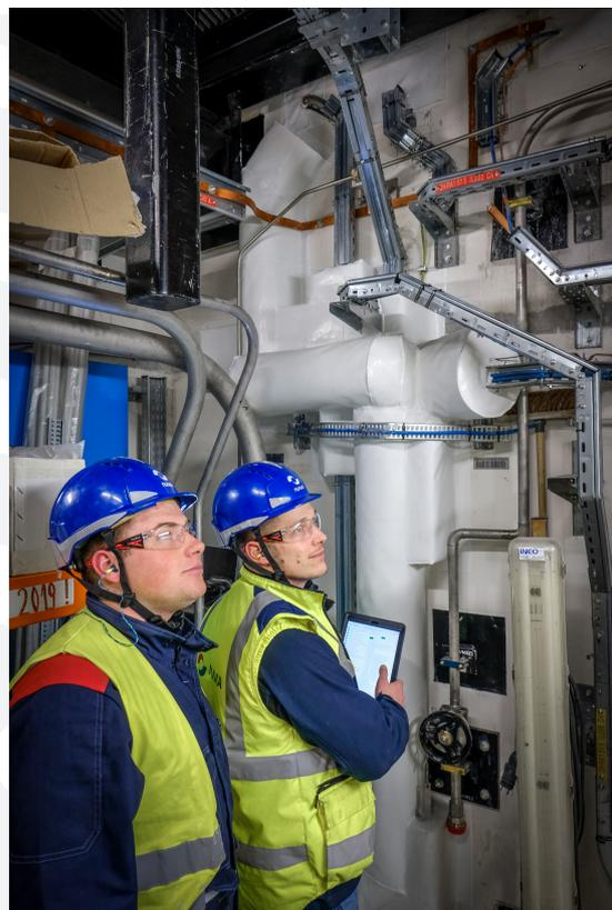
NuFCT 5110 est une protection souple, assurant une fonctionnalité du chemin de câbles protégés jusqu'à 2h sous feu ISO. Elle est adaptable à l'environnement. Cette protection est composée de laine minérale, de colle réfractaire et d'un tissu de protection. Ce complexe a une épaisseur de 80 mm
