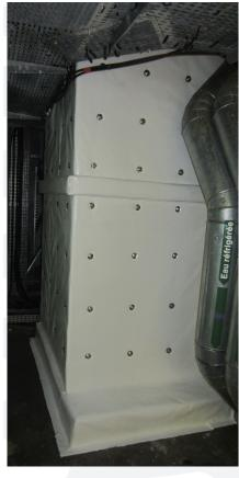
NuDUCT 5111 est une protection souple, assurant une protection jusqu'à 3 heures selon la configuration. Elle est adaptable à l'environnement. Cette protection est composée de laine minérale, de colle réfractaire et d'un tissu de protection. Ce complexe a une épaisseur de 80 mm
